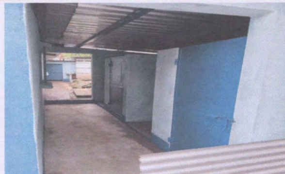
Foto 2: Construcción y techado de baños
