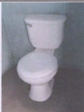
Foto 3: Sanitario instalado con sus accesorios
