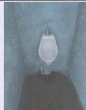
Foto 4: Mingitorio instalado con sus accesorios
